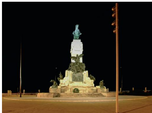
Εικόνα 3.9: Φωτισμός αγάλματος από μακριά και σε σκοτεινό υπόβαθρο The Havana Cuba: Casa Pedroso and Parque Mace (Πηγή: External lighting systems, iGuzzini, 2011-2012 ).
