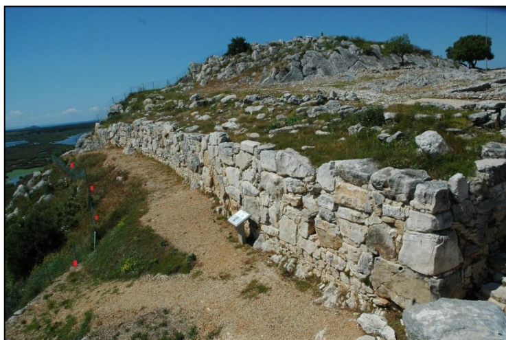
Εικόνα 5.13: Ενδεικτική θέση φωτιστικών σωμάτων (κόκκινο χρώμα) στο ανατολικό τμήμα του Τείχους Δυμαίων (Πηγή: Ιδία επεξεργασία)
