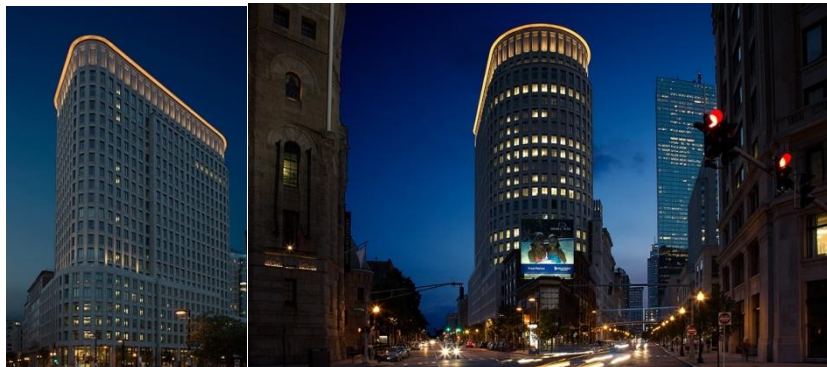
Εικόνα 2.8: Φωτισμός τονισμού (accent lighting), Liberty Mutual Building (Πηγή: Project of lumenpulse, http://www.lumenpulse.com/ )
