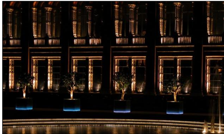
Εικόνα 2.10: Φωτισμός περιγράμματος (silhouetting) London, United Kingdom: Garden of the Victoria & Albert Museum (Πηγή: External lighting systems, iGuzzini, 2011-2012)
