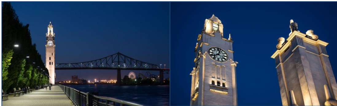
Εικόνα 2.3: Φωτισμός από κάτω προς τα πάνω ( up lighting ), Montreal Clock Tower Pier (Πηγή: Project of lumenpulse, http://www.lumenpulse.com/ )
