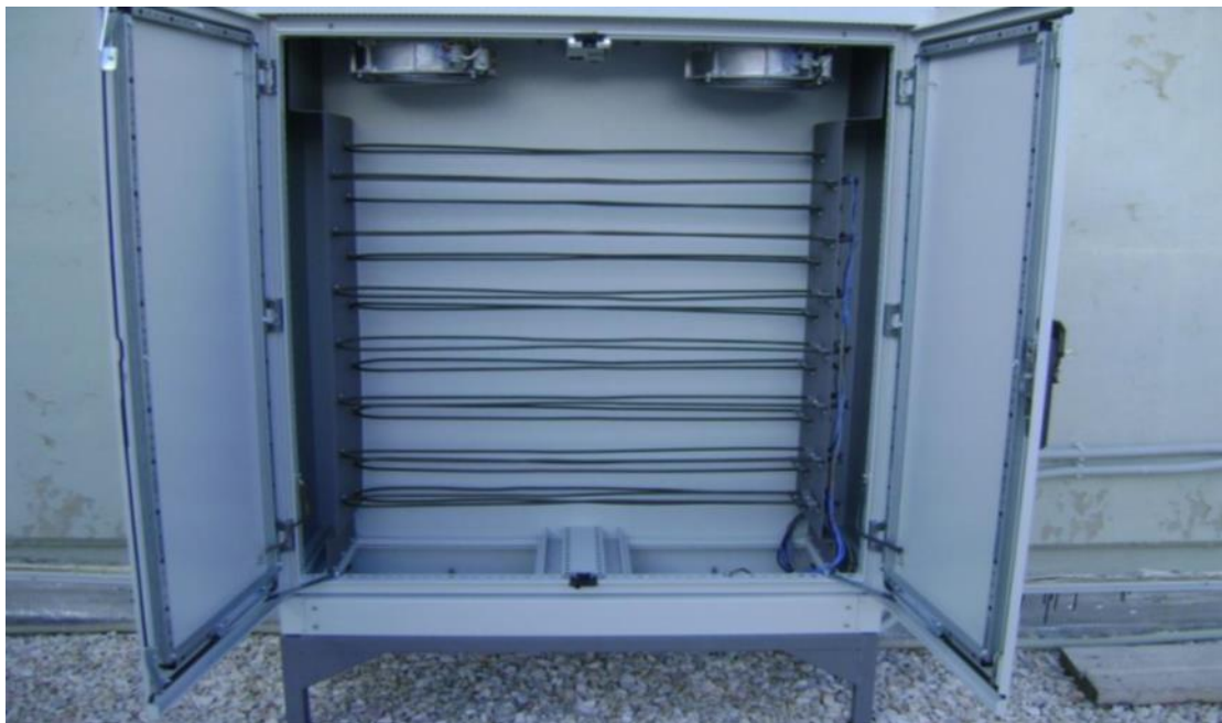
Σχήμα 2.4 Οι αντιστάσεις που έχουν εγκατασταθεί στο μικροδίκτυο
