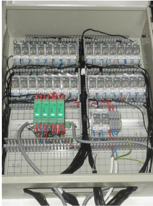
Εικόνα 3.1 Πίνακας με ρελέ του εργαστηρίου
