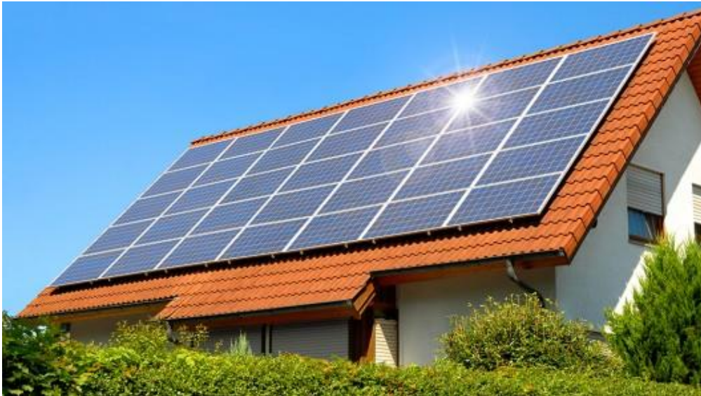
Σχήμα 1.3 Εγκατεστημένα φωτοβολταϊκά πάνελ στη στέγη οικίας για την μετατροπή της ηλιακής ακτινοβολίας σε ηλεκτρική ενέργεια
