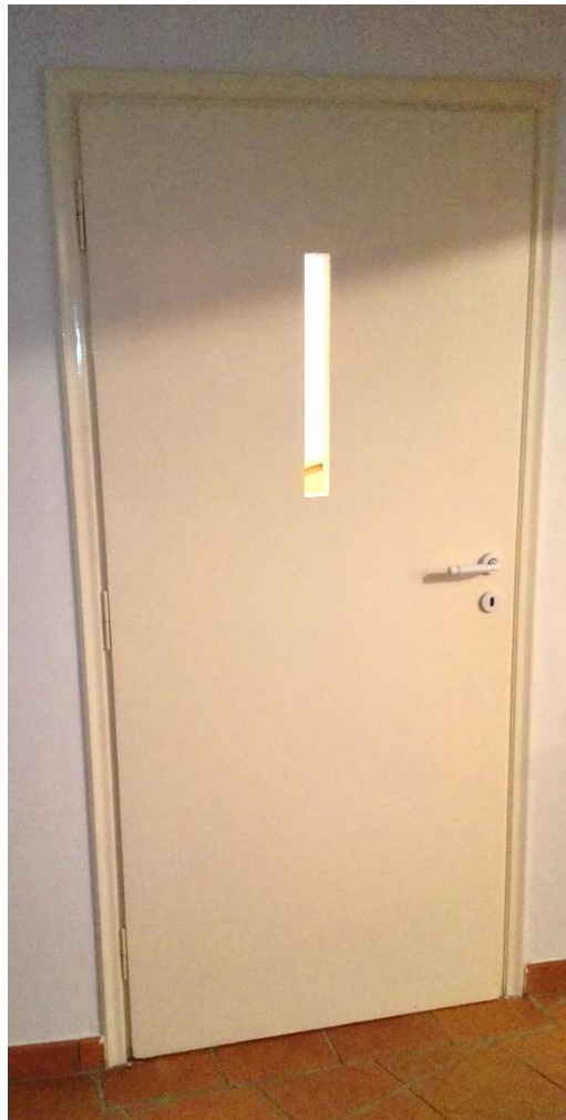
ΕΙΚΟΝΑ 8.4 Η ΠΟΡΤΑ ΤΗΣ ΜΕΣΟΤΟΙΧΙΑΣ ΤΩΝ ΔΥΟ ΔΩΜΑΤΙΩΝ ΜΕ ΕΝΑ ΑΝΟΙΓΜΑ ΣΤΟ ΚΕΝΤΡΟ ΤΗΣ, ΟΠΩΣ ΑΥΤΗ ΦΑΙΝΕΤΑΙ ΑΠΟ ΤΟ ΔΩΜΑΤΙΟ ΛΗΨΗΣ
