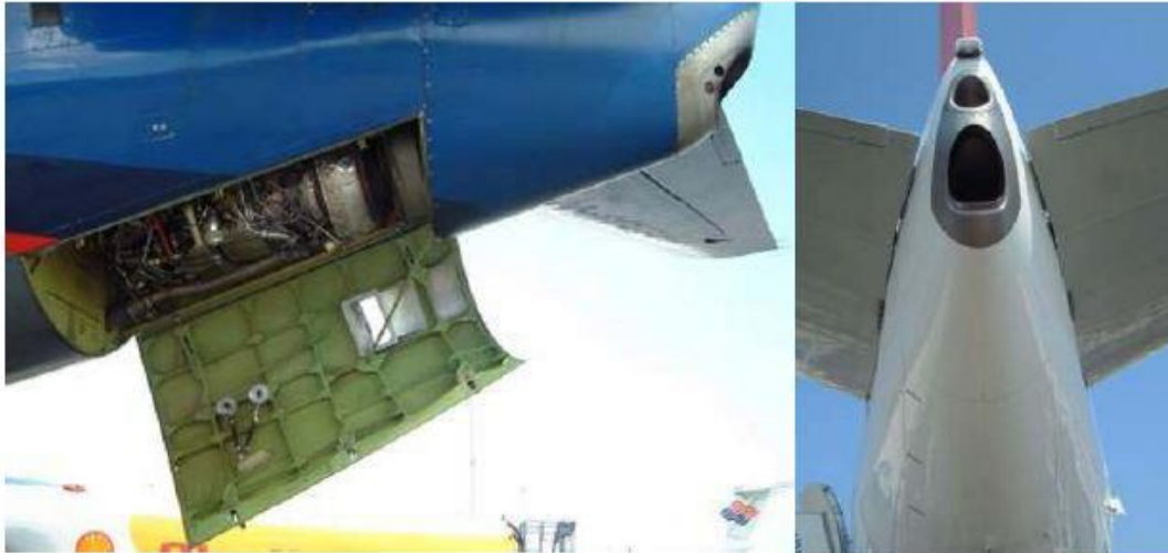
Εικόνα 7 Η θέση της βοηθητικής μονάδας σε ένα Boeing 737. Στα δεξιά διακρίνεται, πάνω από την εξάτμιση και η οπή για την εισαγωγή αέρα για την ψύξη της γεννήτριας. Προσφορά του C. Brandy, The 737 information site
