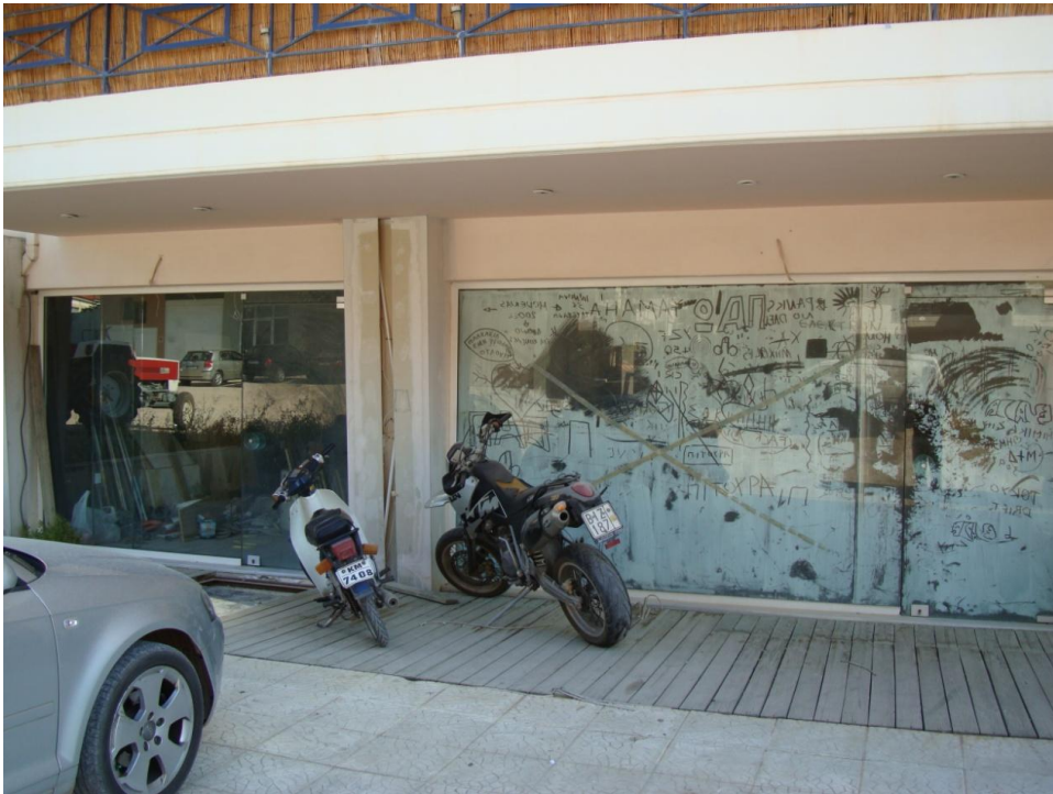
Εικόνα 3.3: Ισόγειο Νότιου Τμήματος του Συγκροτήματος
