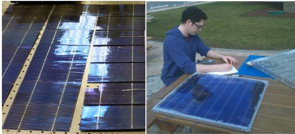
Εικόνα 3.10 : Κατασκευή Ηλιακού Φωτοβολταϊκού πάνελ
