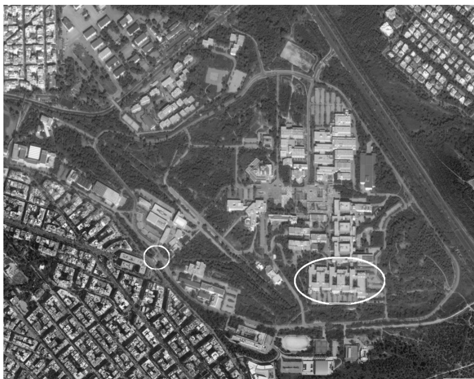
Σχήμα 67 - Πύλη Ζωγράφου αριστερά και Παλιά Κτίρια Ηλεκτρολόγων δεξιά
