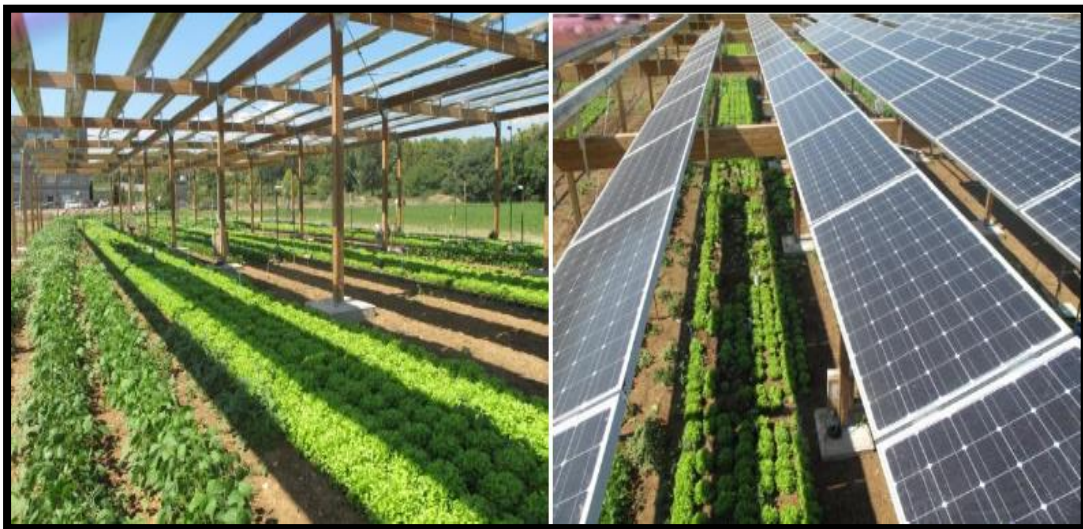
Εικόνα 4.1: Ένα πρότυπο ένα αγροτοφωτοβολταϊκό σύστημα που συνδυάζει ηλιακούς συλλέκτες και καλλιέργειες. Το ύψος τοποθέτησης των πλαισίων στα 4 μέτρα επιτρέπει την εύκολη επεξεργασία του συστήματος με μηχανήματα. Τοποθεσία: Μονπελιέ, Γαλλία
