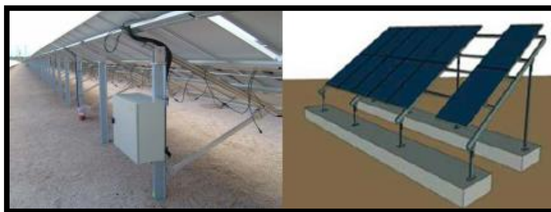
Εικόνα 3.28: Εδαφόμενη βάσεων (αριστερά) και σκυροδέτηση σε δοκάρι (δεξιά) Πηγή: TEE TMK [1]
