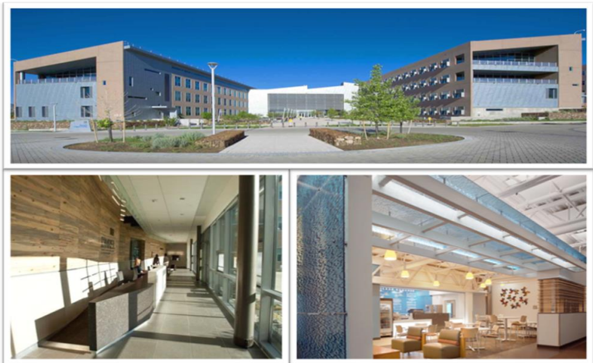
Φωτ. Υλικό 13 Άποψη του εξωτερικού και του εσωτερικού του RSF στο Colorado των ΗΠΑ
