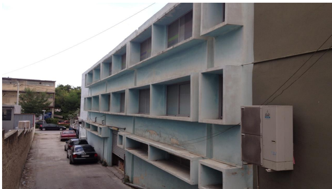
Εικόνα 2.4: Όψη Γ' κτιρίου προς ράμπα υπογείου
