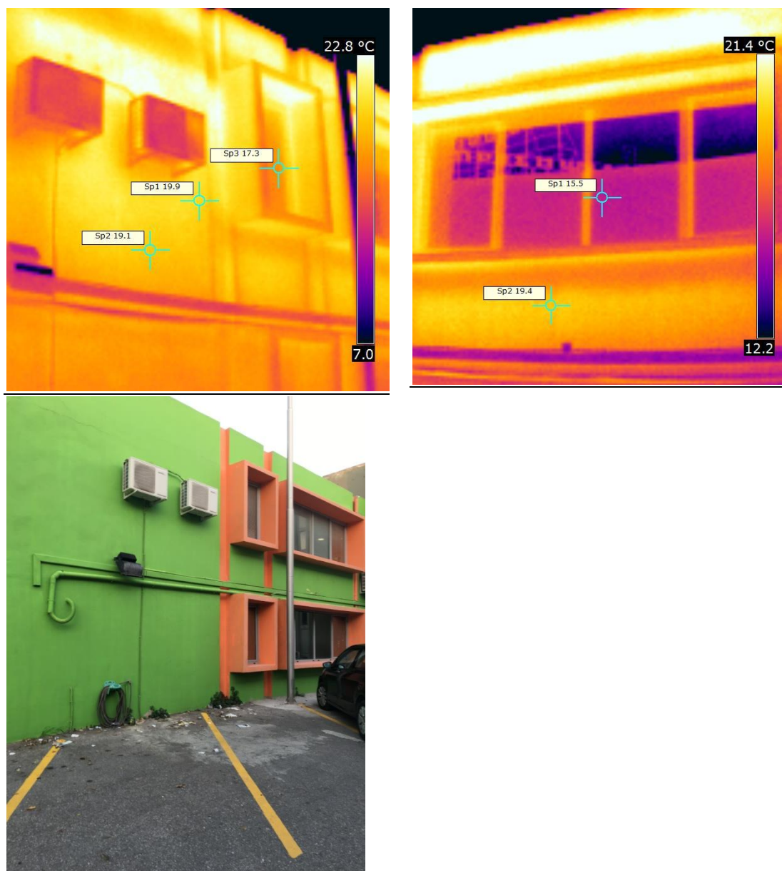
Εικόνα 3.8: Όψη προς ακάλυπτο χώρο (ΝΔ)
