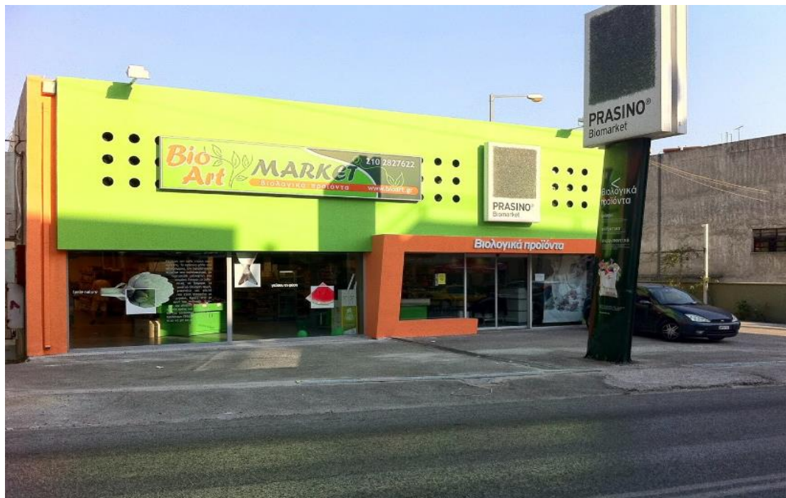
Εικόνα 2.2: Όψη Α' κτιρίου προς τη Λεωφόρο Ηρακλείου
