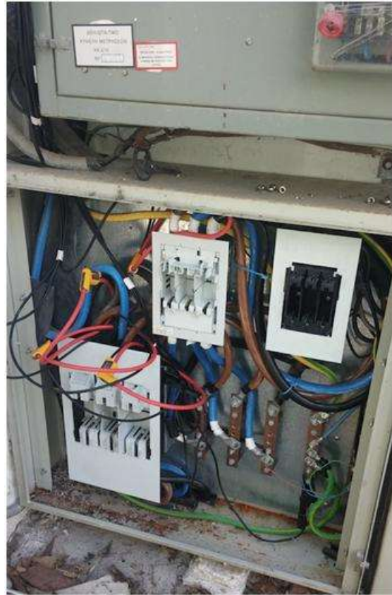
Εικόνα 4.24β: Σύνδεση αναλυτή ηλεκτρικής ενέργειας στον πίνακα του συγκροτήματος
