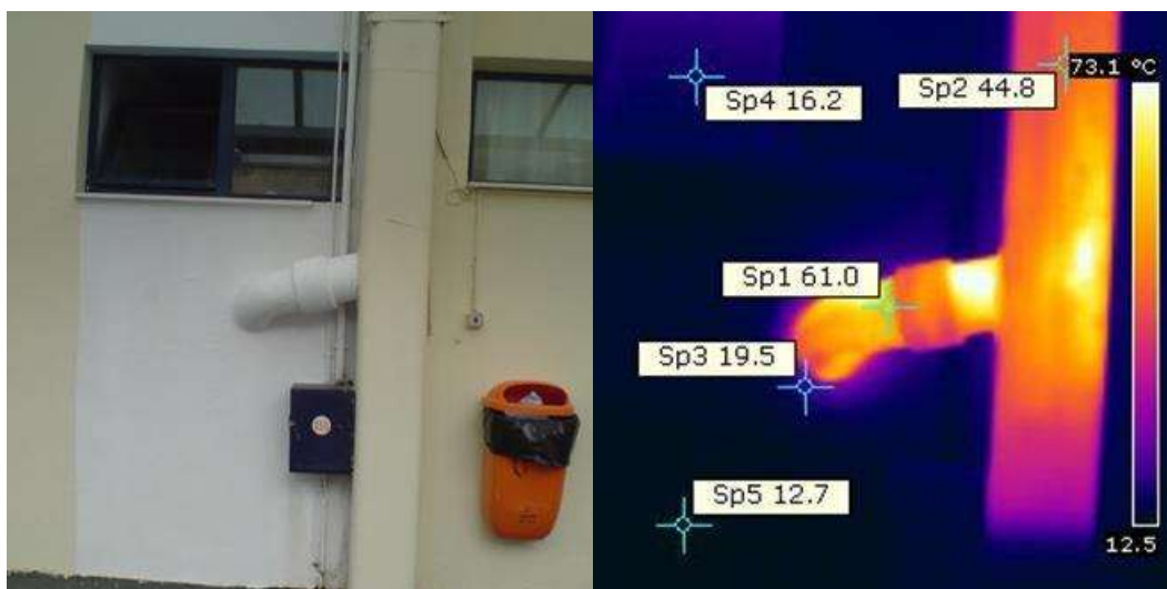
Εικόνα 4.8: Το λεβητοστάσιο στην πίσω όψη του Γυμνασίου
