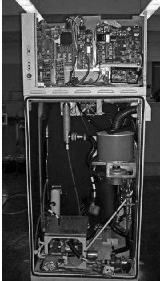
Σχήμα 20: Μία διάταξη κυψελών καυσίμου 5 kW με μετατροπέα 60Hz της Plug Power Corporation. [20]
