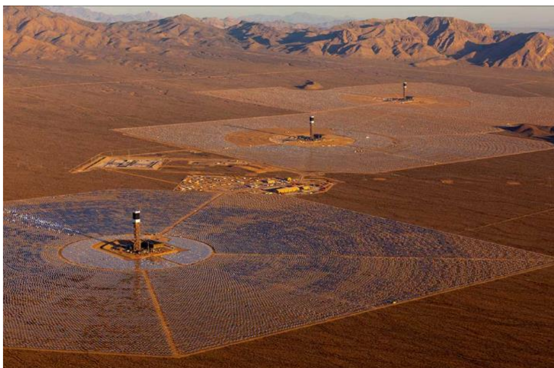
Εικόνα 5.8: Αεροφωτογραφία του σταθμού ISEGS όπου φαίνονται και οι τρεις μονάδες του
