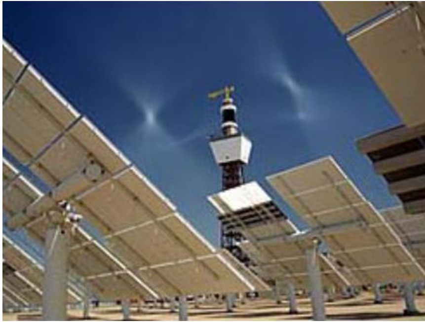
Εικόνα 3.2: Φωτογραφία συστήματος ηλιακού πύργου ισχύος από το πεδίο των ηλιοστατών
