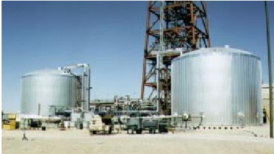
Εικόνα 5.2: Φωτογραφία των δύο δεξαμενών αποθήκευσης του Solar Two
