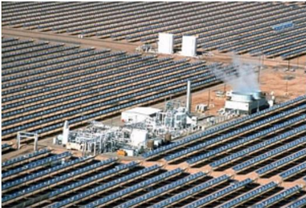
Εικόνα 2.2: Φωτογραφία από το σταθμό του Solar Electric Generating Station IV στην Καλιφόρνια στις Η.Π.Α, όπου χρησιμοποιείται τεχνολογία Παραβολικών Κοίλων
