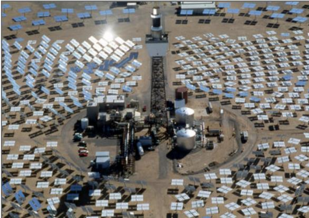
Εικόνα 3.1: Φωτογραφία συστήματος ηλιακού πύργου ισχύος
