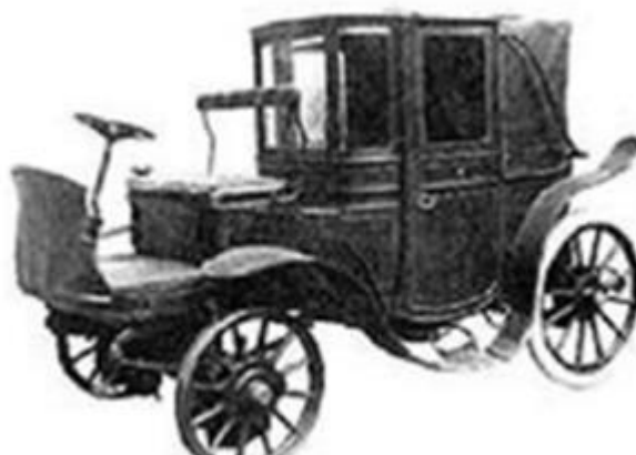
Σχήμα 1.2: Αυτοκίνητο που κατασκευάστηκε από την Krieger το 1903 και χρησιμοποιεί έναν βενζινοκινητήρα για να υποστηρίξει συστοιχία τριών μπαταριών.
