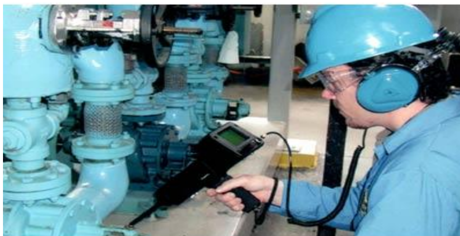
Εικόνα 3.1: Προληπτική συντήρηση με χρήση υπερήχων.
