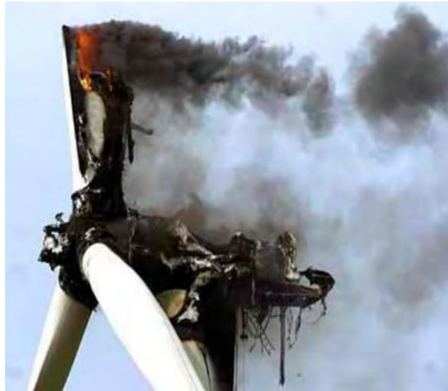
Σχήμα 1.13: Καταστροφή ανεμογεννήτριας λόγω εσφαλμένης αντικεραυνικής προστασίας [4]
