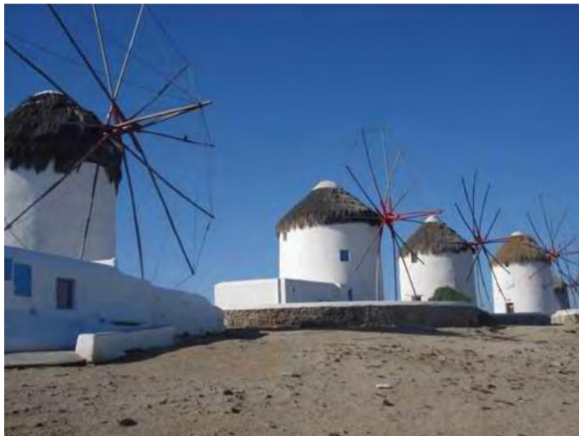
Σχήμα 1.2: Ανεμόμυλοι στο νησί της Μυκόνου
