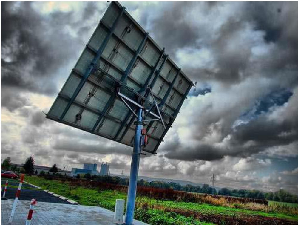
Εικόνα 27 σύστημα ιχνηλάτησης διπλού άξονα 1
