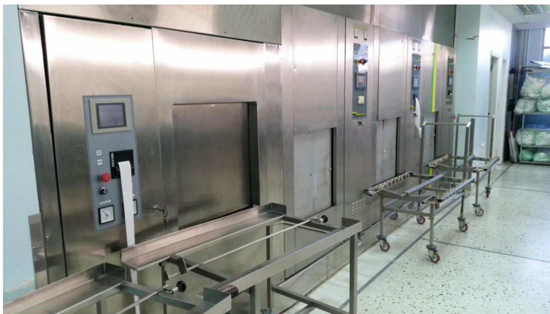
Σχήμα 5.1.6-1 Κλιβανοί νοσοκομείου ΚΑΤ
