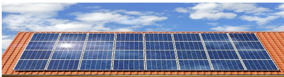
Εικόνα 4-1 φωτοβολταϊκή συστοιχία σε σκεπή οικίας
