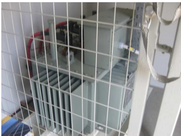
Φωτογραφία. 9: Μετασχηματιστής ιδιοκαταναλώσεων
