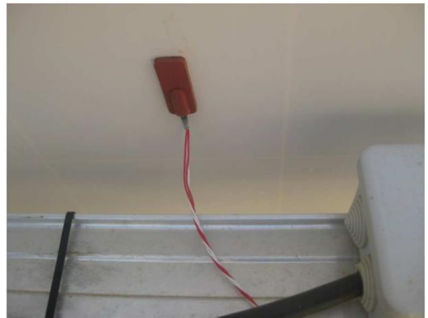
Φωτογραφία. 14: Αισθητήρας θερμοκρασίας Φ/Β πάνελ
