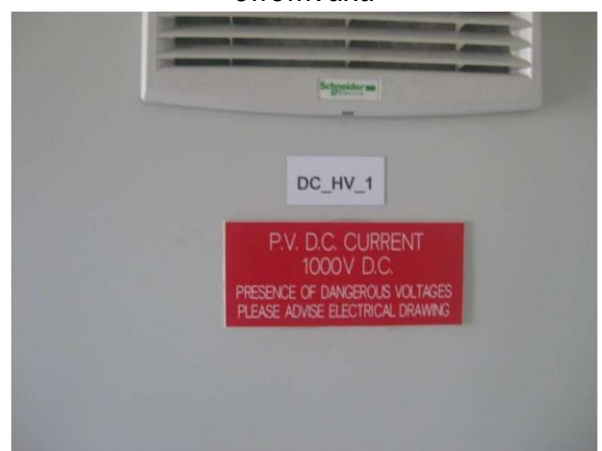
Φωτογραφία. 6: Πινακίδα στοιχείων DC υποπίνακα
