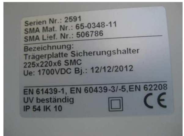
Φωτογραφία. 6: Πινακίδα στοιχείων DC υποπίνακα
