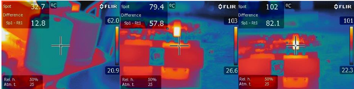
Σχήμα 8.2: Θερμικές εικόνες πρωτότυπου τυπωμένου κυκλώματος. Αριστερά απεικονίζεται η θερμοκρασία των πυκνωτών εξόδου, στο κέντρο η θερμοκρασία των διακοπτικών στοιχείων και δεξιά η θερμοκρασία του δακτυλιδιού φερρίτη.
