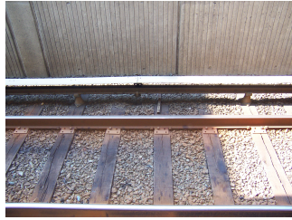
Σχήμα 2.4: Παράδειγμα γραμμής παροχής ηλεκτρικής ισχύος (750V).
