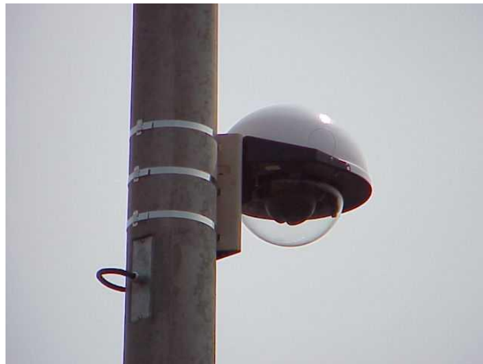
Σχήμα 2.3. Παράδειγμα βιντεοκάμερας προσαρτημένης σε στύλο διανομής ηλεκτρικής ενέργειας [www.gatewayguide.com].
