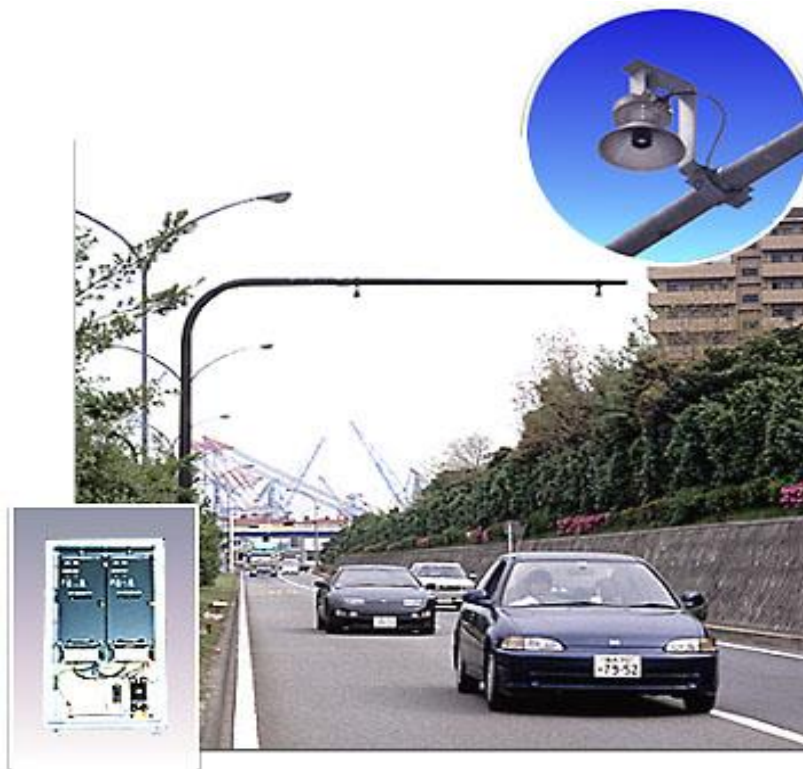
Σχήμα 2.8. Παράδειγμα υπερηχητικού αισθητήρα τοποθετημένου σε ιστό άνω του οδοστρώματος. Στην βάση του ιστού είναι εγκατεστημένος ο συλλέκτης [ www.utms.or.jp ].
