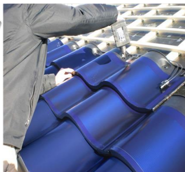
Εικόνα 3.3: Ηλιακά «κεραμίδια» Με εκτύπωση σε ρολό, εύκαμπτων φωτοβολταϊκών μεμβράνης
