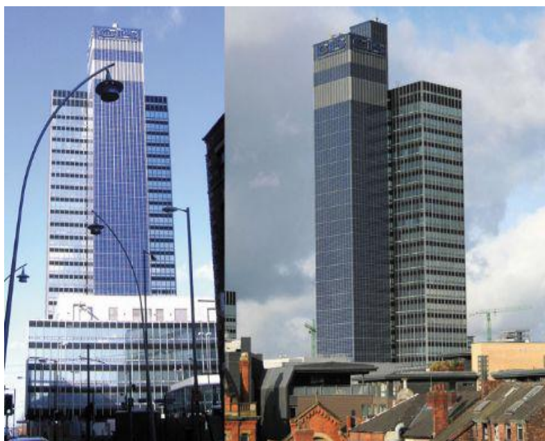
Εικόνα 3.2 : Ο πύργος CIS στο Manchester της Μ. Βρετανίας με φωτοβολταϊκή πρόσοψη
