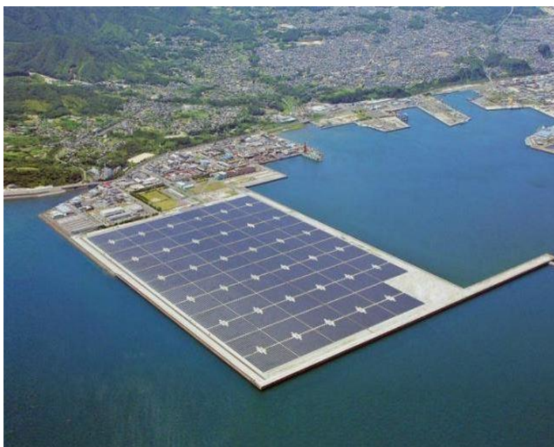
Εικόνα 3.6 : Το μεγαλύτερο ηλιακό πάρκο στην Ιαπωνία, με ισχύ 70 MW
