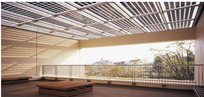
Εικόνα 3.5 : Ενσωμάτωση φωτοβολταϊκών σε στέγαστρα
