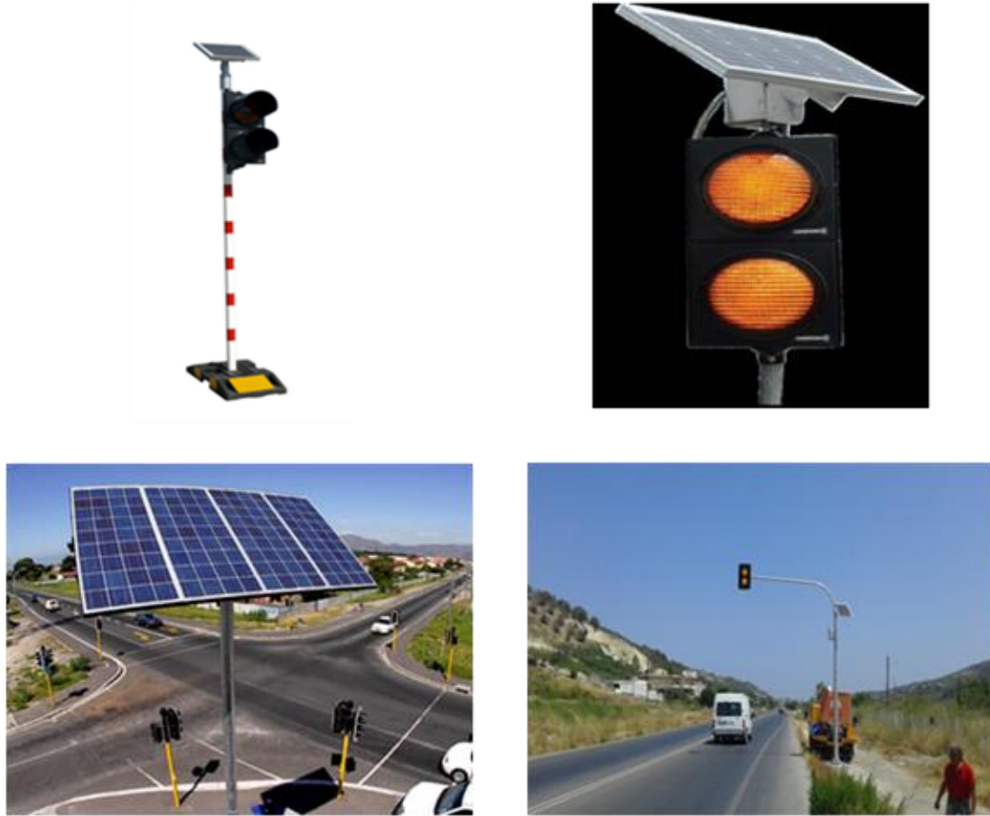
Εικόνα 6: Εγκαταστάσεις Φ/Β στη φωτεινή σηματοδότηση
