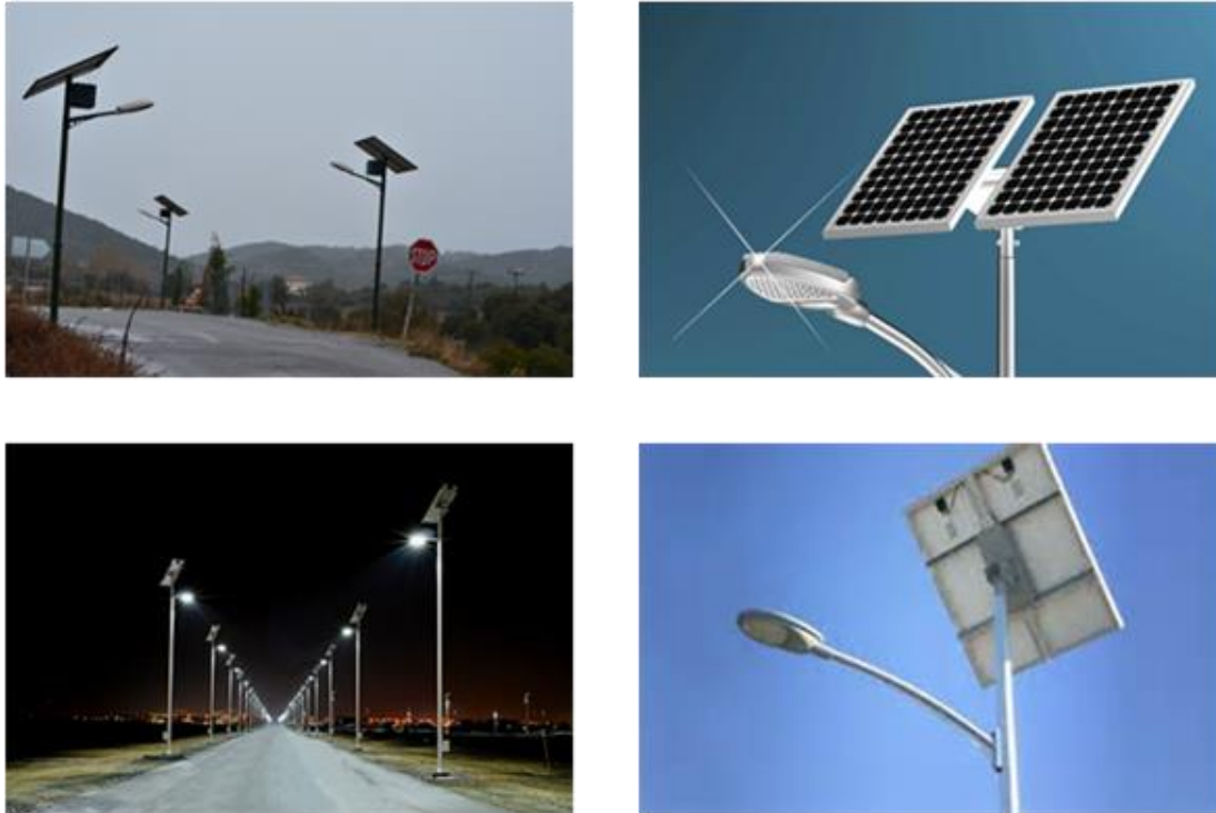
Εικόνα 4: Οδοφωτισμός με χρήση Φ/Β συστημάτων
