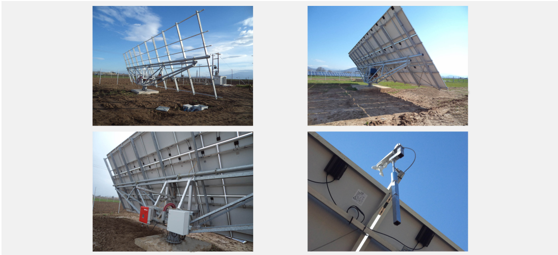
Σχήμα 1.14: Βάση φωτοβολταϊκών πλαισίων με σύστημα ιχνηλάτησης [34]
