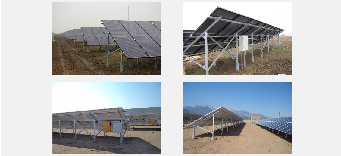
Σχήμα 1.13: Σταθερές βάσεις στήριξης φωτοβολταϊκών πλαισίων υπό γωνία 30° [33]
