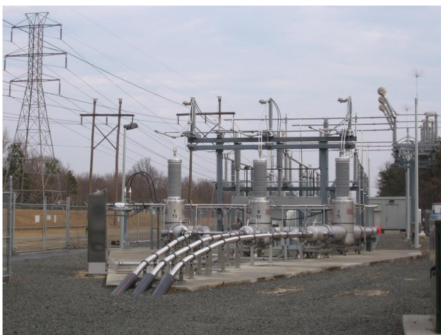
Δίκτυο υπεραγωγίων καλωδίων τάσης 138 kV.
