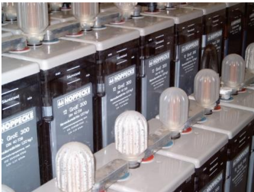
Εικόνα 4.5: Σύστημα καταλύτη ανασυνδυασμού νερού
