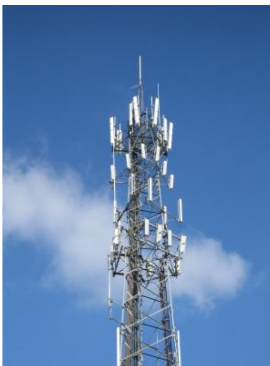
Εικόνα 2.9: Σταθμός βάσης κινητής τηλεφωνίας
