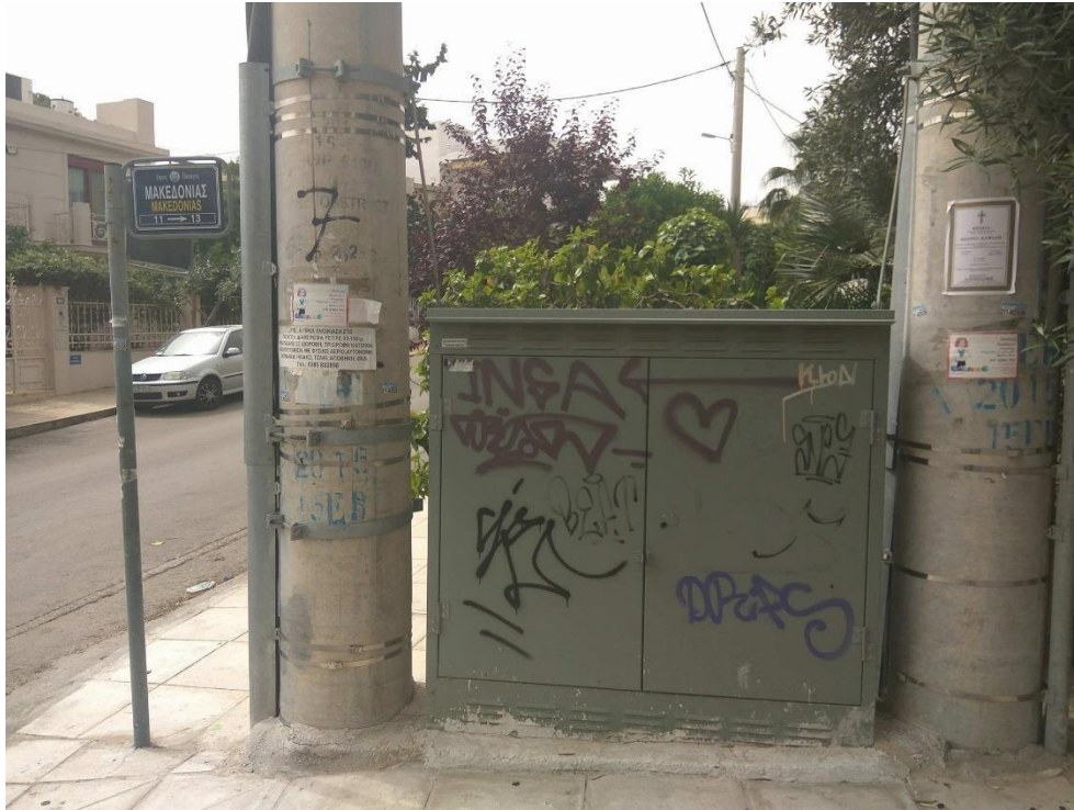
4. δίστυλος υποσταθμός επί της Οδού Μακεδονίας
