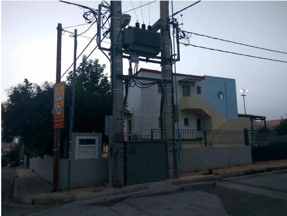
Εικόνα 4. Δίστυλος υποσταθμός επί της Οδού Κλειτάρχου
