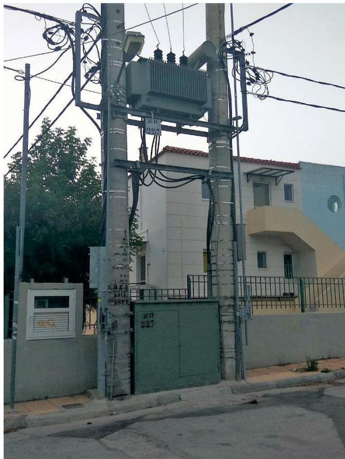
Εικόνα 2.7 Δίστυλος υποσταθμός διανομής
