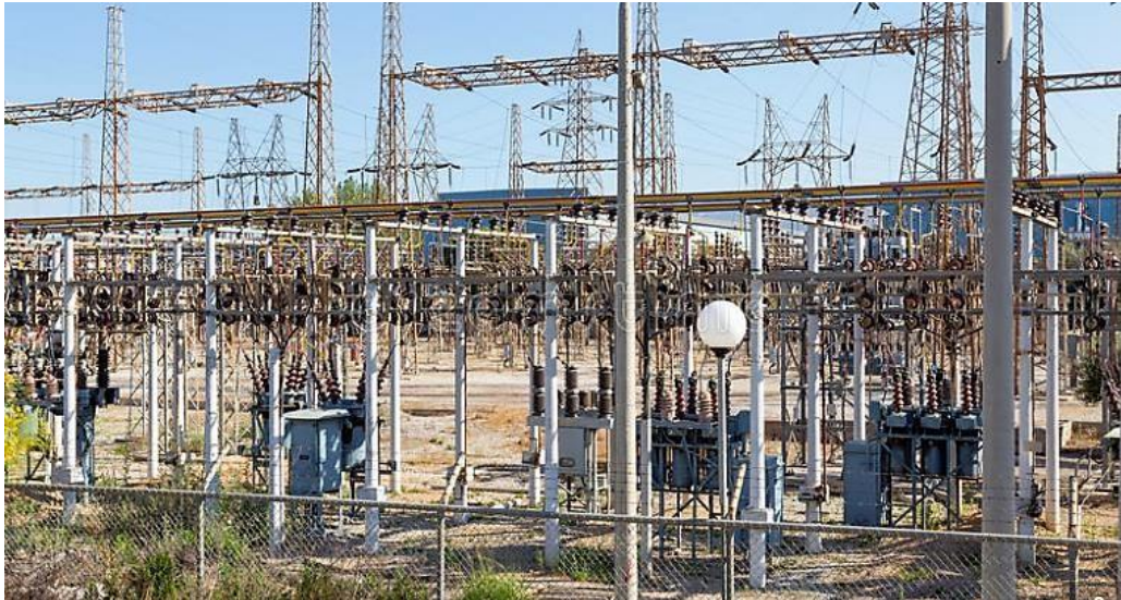
Εικόνα 2.8 : Υποσταθμός υψηλής τάσης
