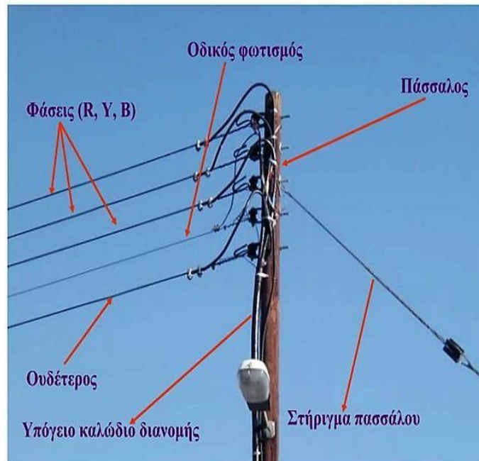
Εικόνα 2.5 Δίκτυο διανομής χαμηλής τάσης
