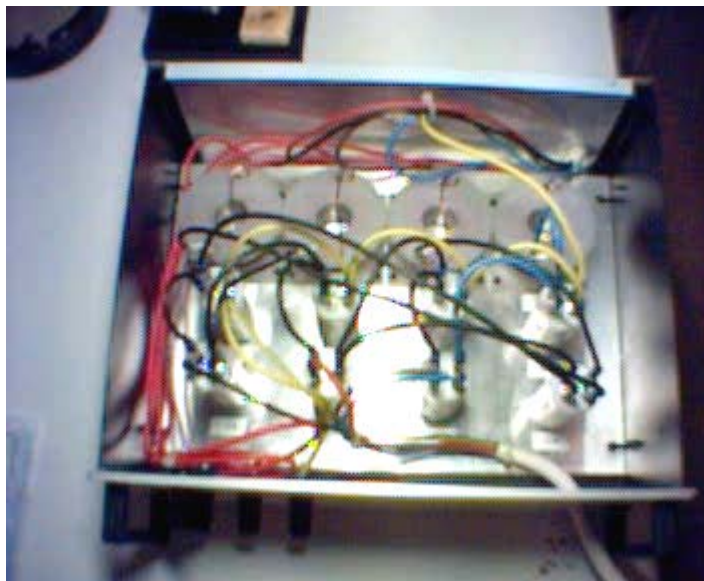
Εικόνα 4.11: Καλωδίωση του υλικού και μάζεμα καλωδίων με δεματικά μετά την τοποθέτηση του σασί μέσα στο κουτί.
