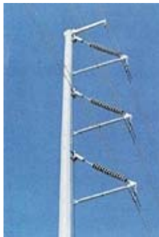
Σχήμα 1.7: Μονωτήρας τύπου post σε γραμμή ΥΤ [5].
