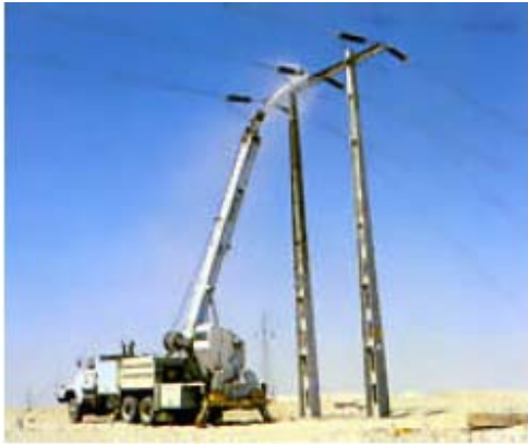
Σχήμα 1.7: Πλύσιμο μονωτήρων σε μια γραμμή μεταφοράς
