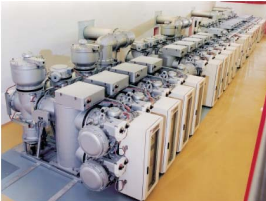
Σχήμα 2.3-1: Εγκατάσταση ΥΤ με μόνωση SF 6 .
