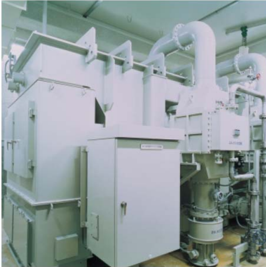
Σχήμα 2.3-6: Μετασχηματιστής με μόνωση SF 6 23-107 kV.
