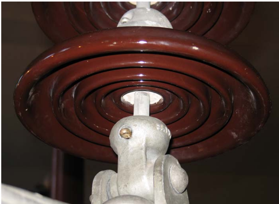
Σχήμα 3.1: Πορσελάνινος δισκοειδής μονωτήρας πορσελάνης, τύπου κανονικού
