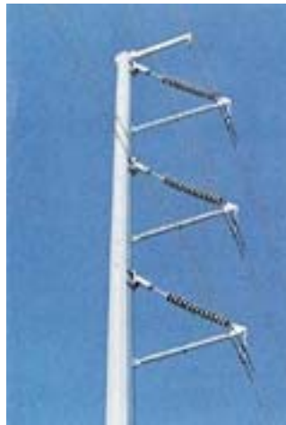
Σχήμα 1.5: Μονωτήρας τύπου post σε γραμμή Υ.Τ.
