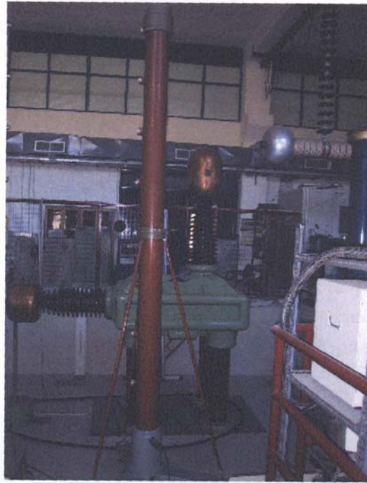
Εικόνα 6-2 : Χωρητικός καταμεριστής τάσης στο Εργαστήριο Υψηλών Τάσεων του Ε.Μ.Π
