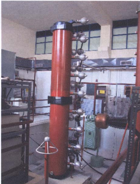
Εικόνα 6-1 : Οκταβάθμια γεννήτρια κρουστικών τάσεων στο Εργαστήριο Υψηλών Τάσεων του Ε.Μ.Π.
