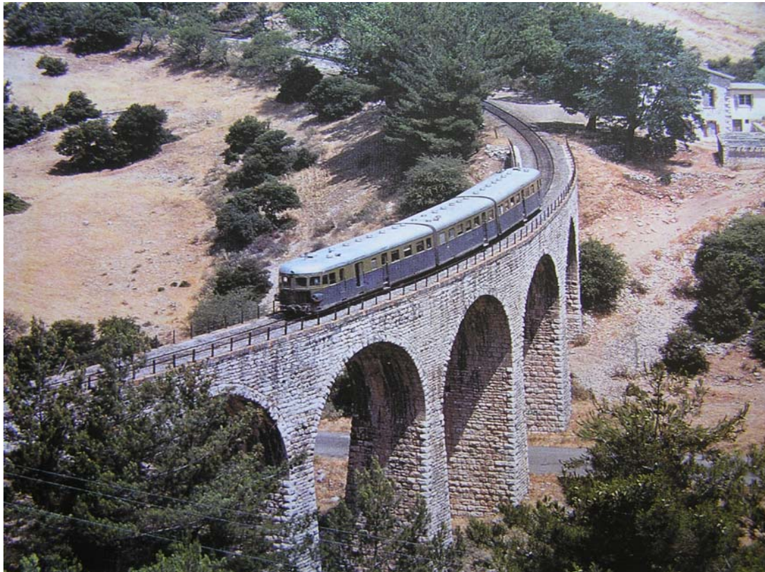
Φωτογραφία 5: Η γέφυρα υπό το φως του ήλιου
