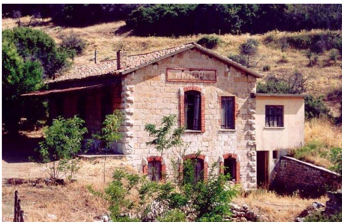
Φωτογραφία 4: Το κτίριο του σταθμού
