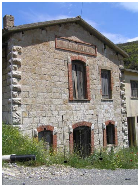
Φωτογραφία 17: Τοποθέτηση φωτιστικών στην μπροστινή όψη του σταθμού.
