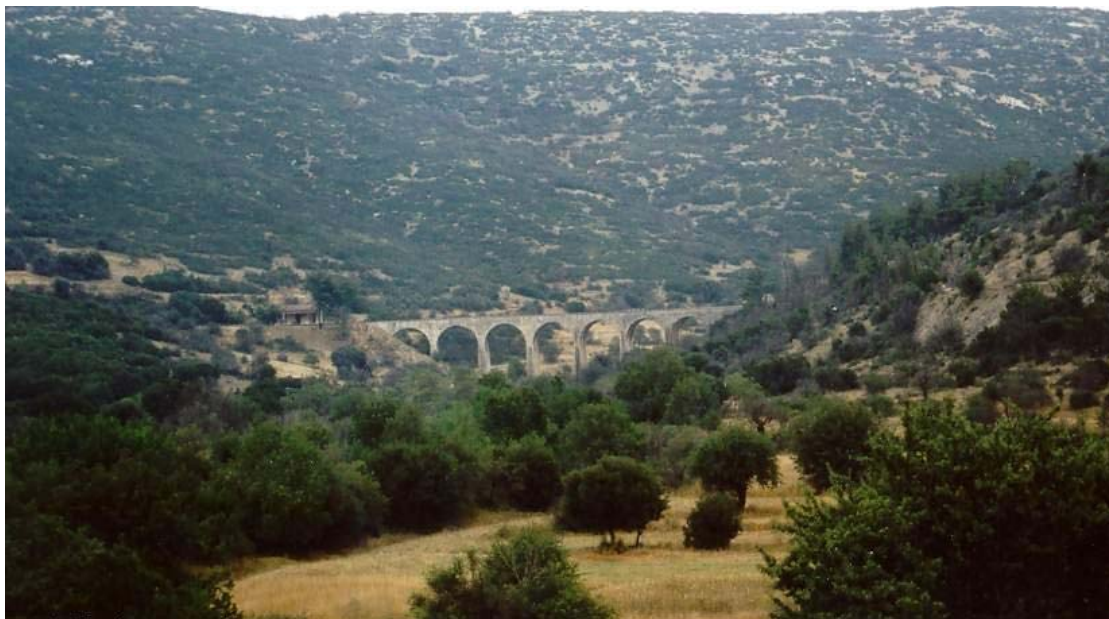
Φωτογραφία 1: Αποψη της γέφυρας από μακριά
