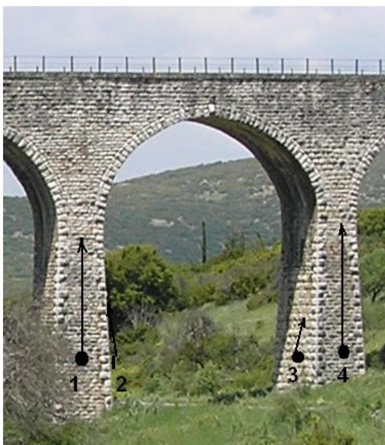
Φωτογραφία 6: Τοποθέτηση των φωτιστικών.
