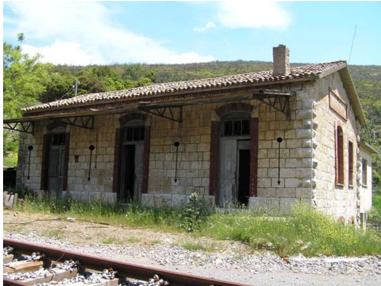
Φωτογραφία 16: Τοποθέτηση φωτιστικών στην πλάγια όψη του σταθμού.
