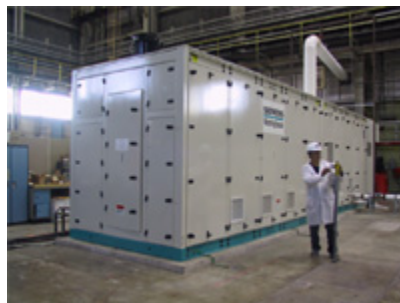
Εικόνα 3.6: Μονάδα SOFC 250 kW ,εγκατεστημένη στην εταιρεία Kinectrics, στο Τορόντο του Καναδά
