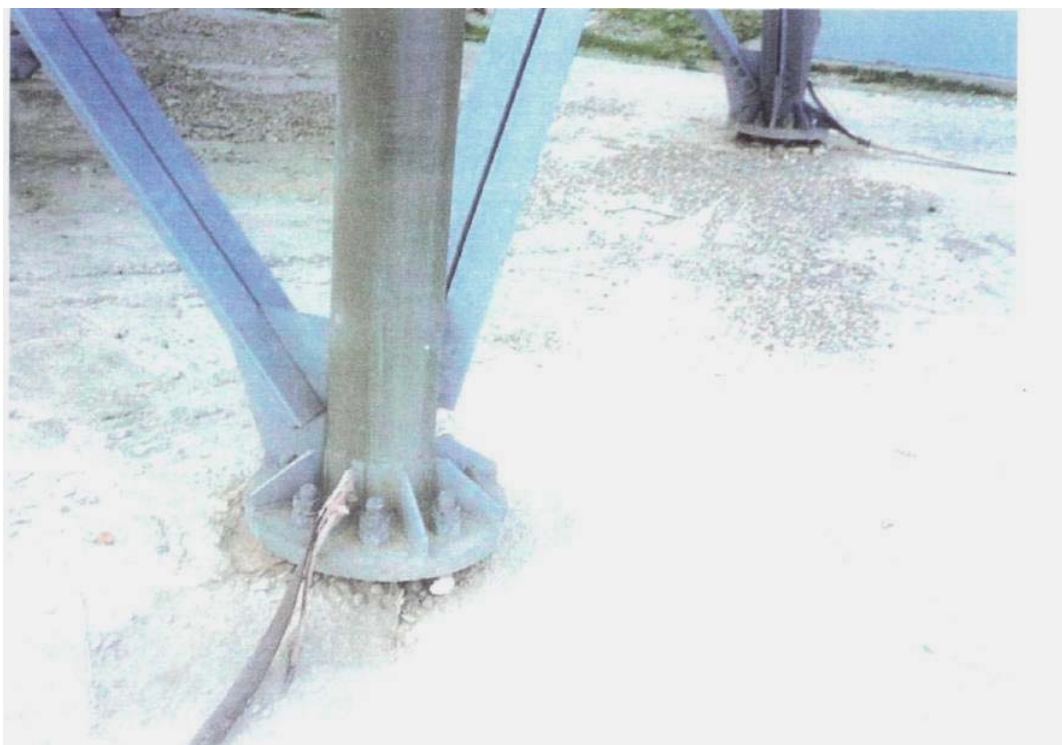
Εικόνα 3.8: Βάση έδρασης του πύργου Radar Λευκάδας
