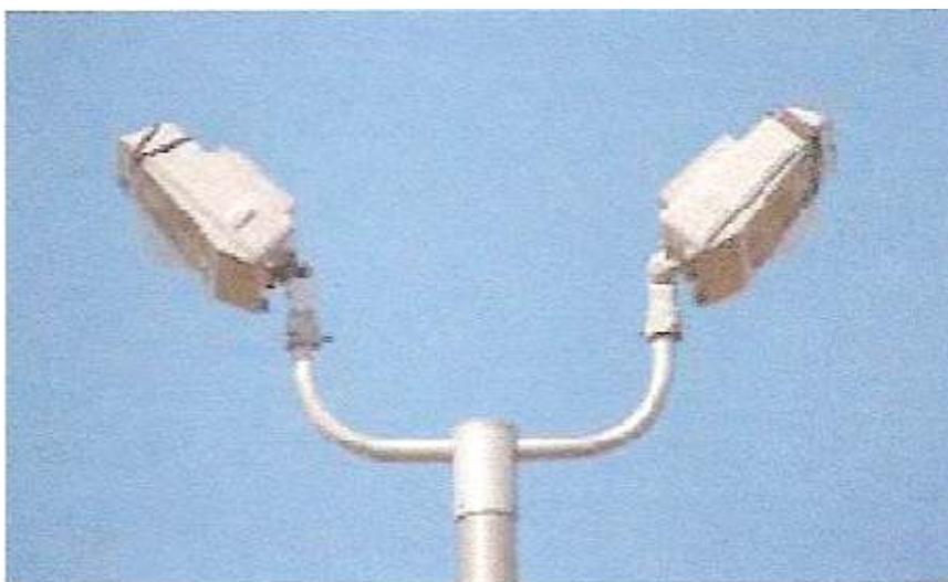
Εικόνα 3.2 Φωτιστικό σώμα οριζόντιας διάταξης
