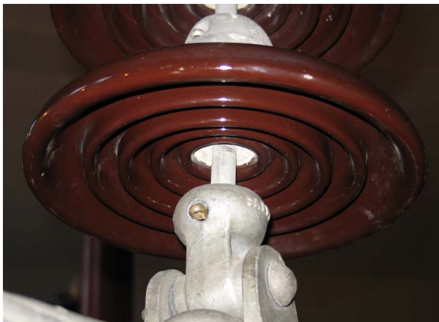
Εικόνα 5.3: Πορσελάνινος δισκοειδής μονωτήρας πορσελάνης, τύπου κανονικού
