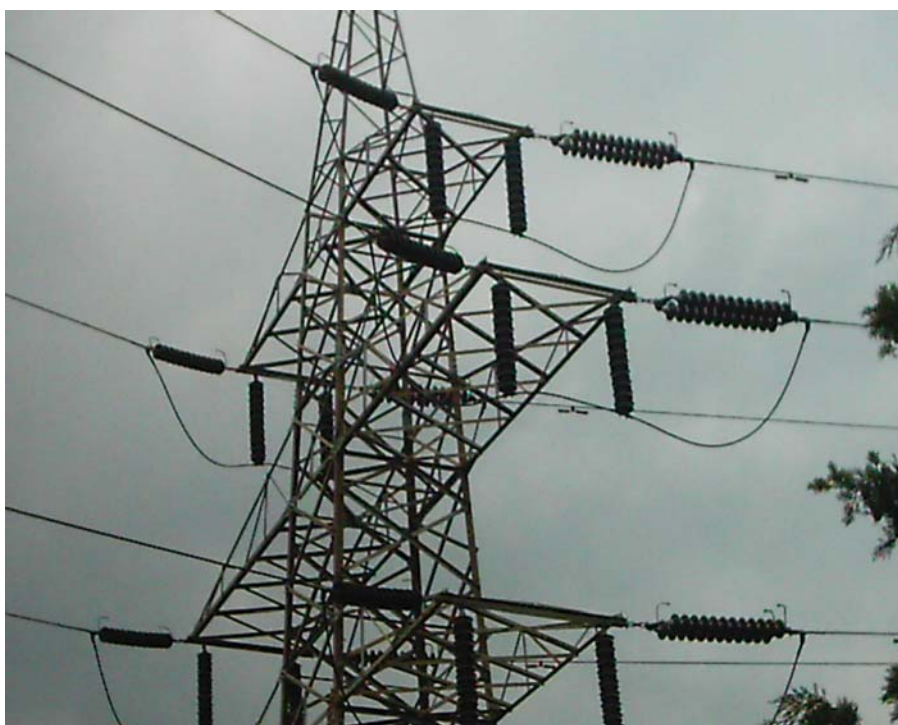
Σχήμα 1.20 Πορσελάνινοι μονωτήρες σε πυλώνες
