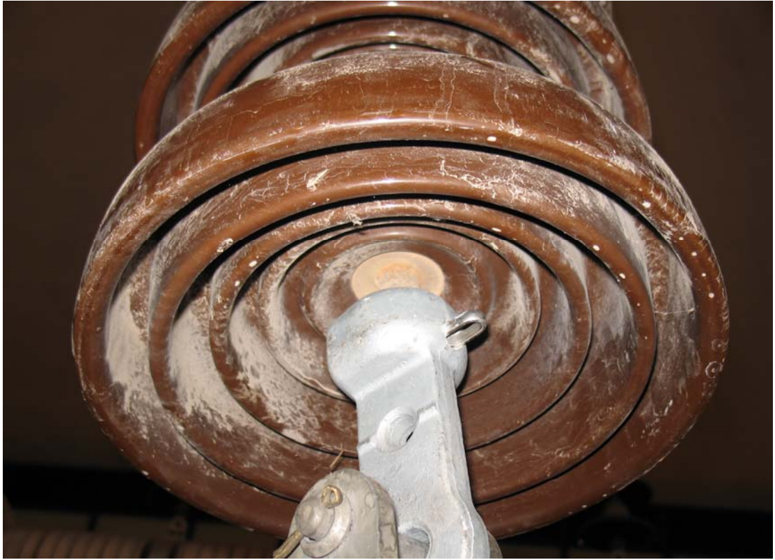
Σχήμα 4.50: Ρυπασμένος πορσελάνινος αλυσοειδής μονωτήρας (100), τύπου ομίχλης 400 kV, αποτελούμενος από δεκαέξι (16) δισκοειδείς μονωτήρες
