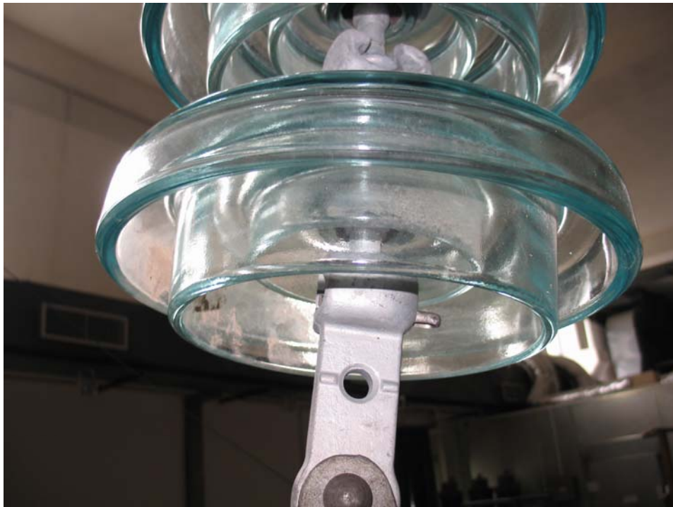
Σχήμα 3.3: Γυάλινος δισκοειδής μονωτήρας, τύπου ομίχλης
