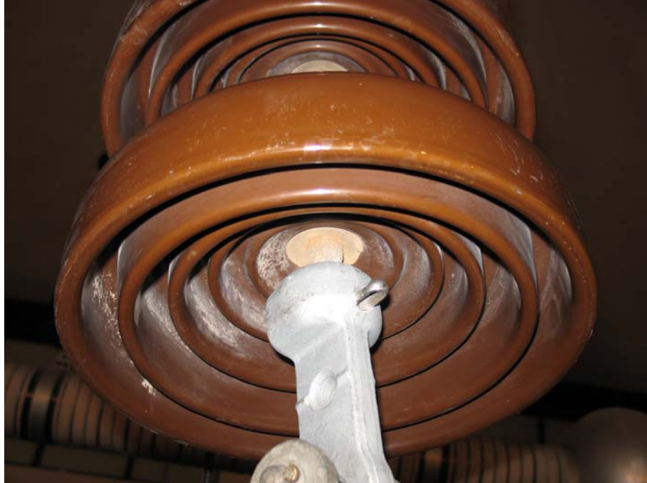
Σχήμα 3.4: Πορσελάνινος δισκοειδής μονωτήρας, τύπου ομίχλης
