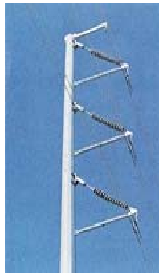
Σχήμα 1.5: Μονωτήρας τύπου post σε γραμμή Υ.Τ.
