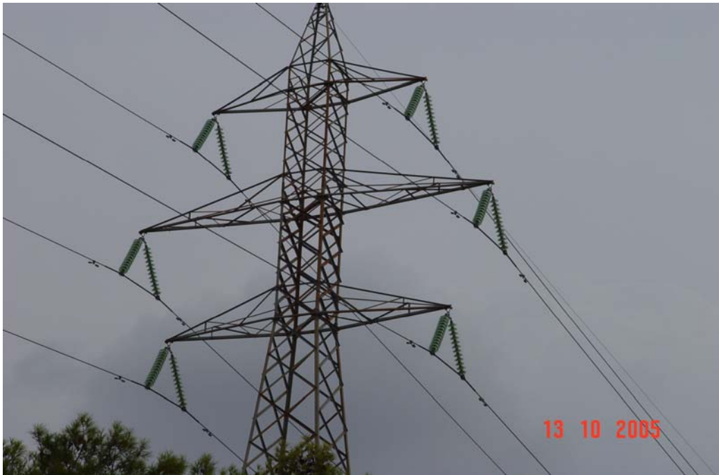
Σχήμα 1.11 Γυάλινοι μονωτήρες σε διάταξη λάμδα.
