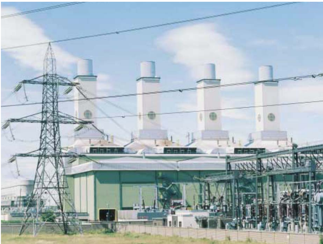
Σχήμα 1.1. Σύγχρονος σταθμός παραγωγής ηλεκτρικής ενέργειας
