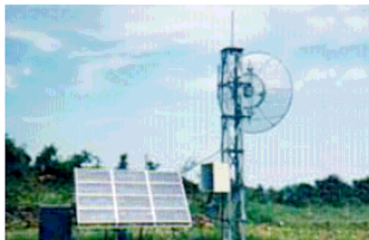
Εικόνα 1.4: Συστήματος Τηλεπικοινωνίας με τροφοδοσία από Φ/Β στην Αρκαδία
