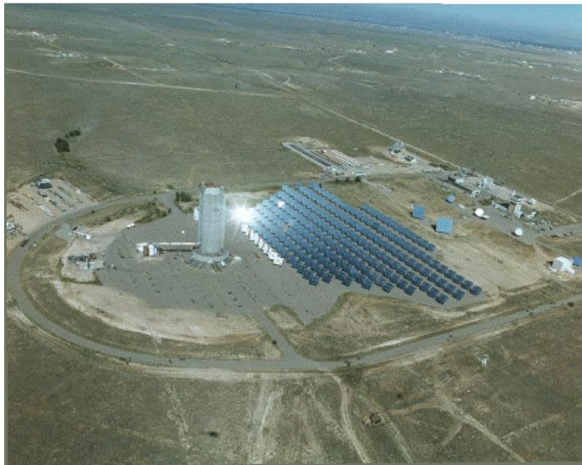
Εικόνα 1.11: Θερμικό ηλιακό σύστημα παραγωγής ηλεκτρικής ενέργειας
