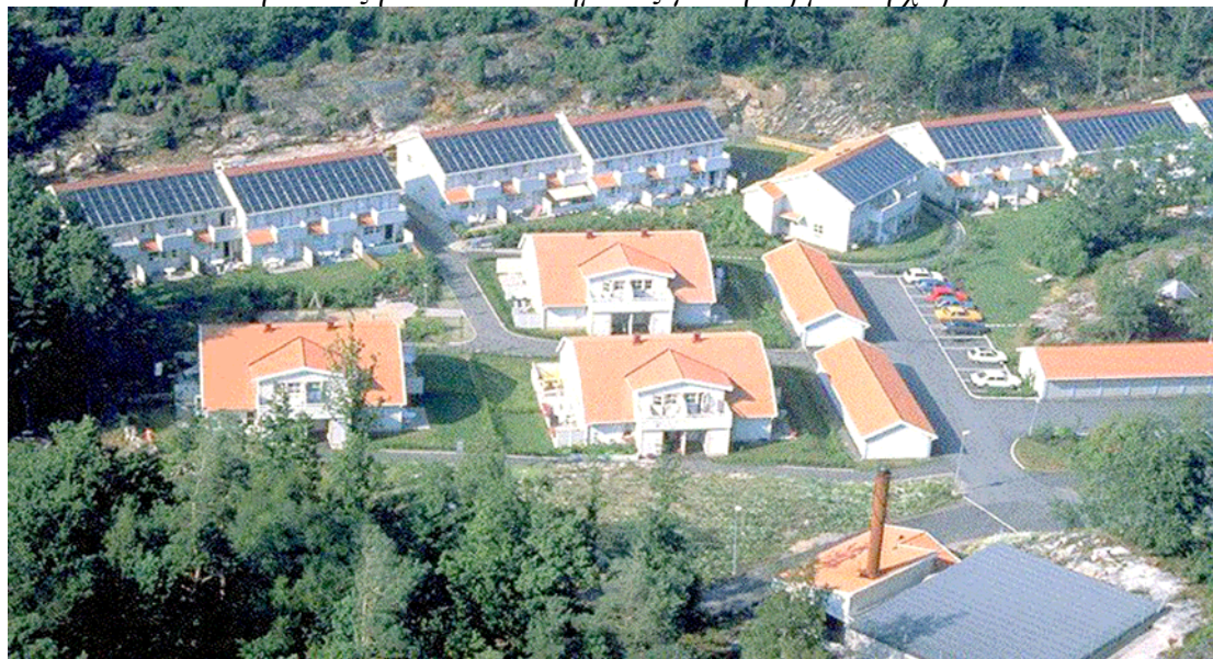
Εικόνα 1.9: Ηλιοθερμικά συστήματα για θέρμανση χώρων στη Σουηδία
