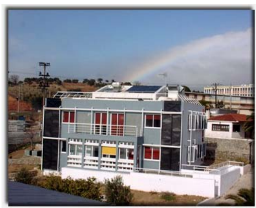
Εικόνα 1.6: Εφαρμογή παθητικού ηλιακού συστήματος σε κτίριο του Κ.Α.Π.Ε.
