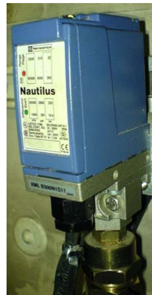
Σχήμα 75 : Διακόπτες πίεσης για το λαδί λίπανση και κατάθλιψη αέρος
