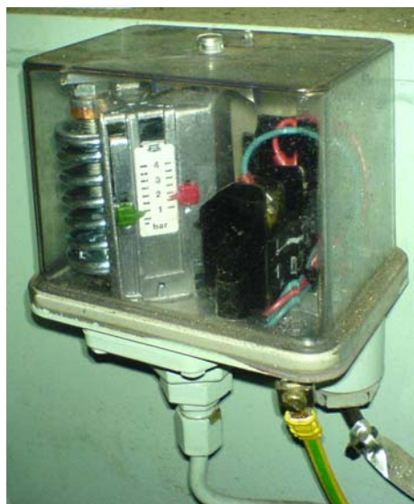
Σχήμα 75 : Διακόπτες πίεσης για το λαδί λίπανση και κατάθλιψη αέρος
