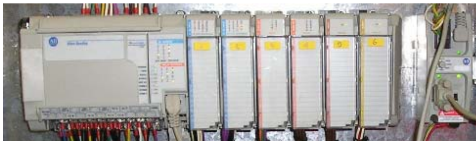
Εικόνα 5. Ο προγραμματιζόμενος λογικός ελεγκτής (PLC) του αντλιοστασίου
