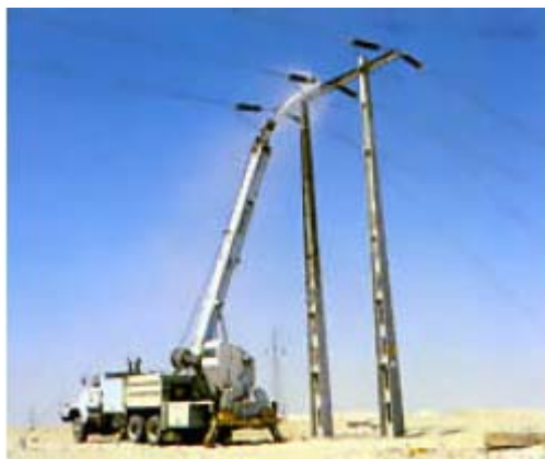
Σχήμα 1.7: Πλύσιμο μονωτήρων σε μια γραμμή μεταφοράς
