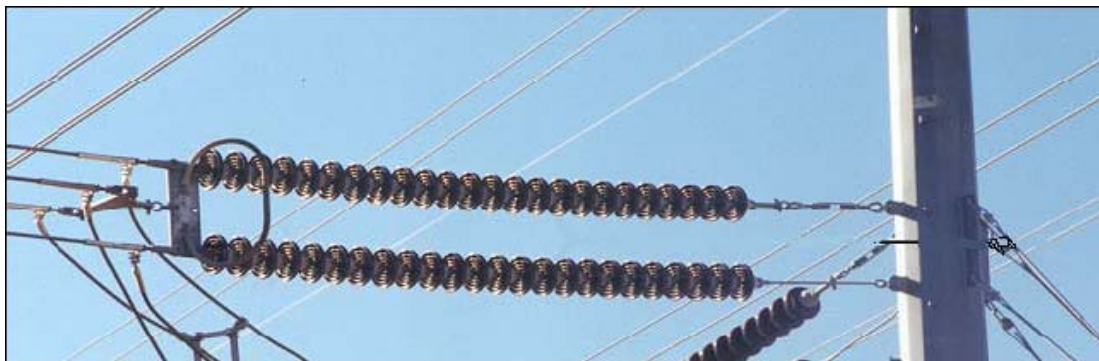
Σχήμα 1.3: Κεραμικοί μονωτήρες σε εναέρια γραμμή.
