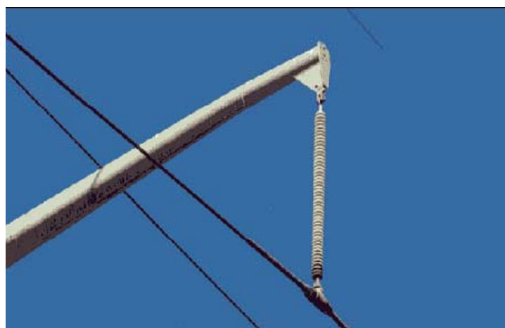
Σχήμα 1.4: Μη-κεραμικός μονωτήρας σε εναέρια γραμμή.
