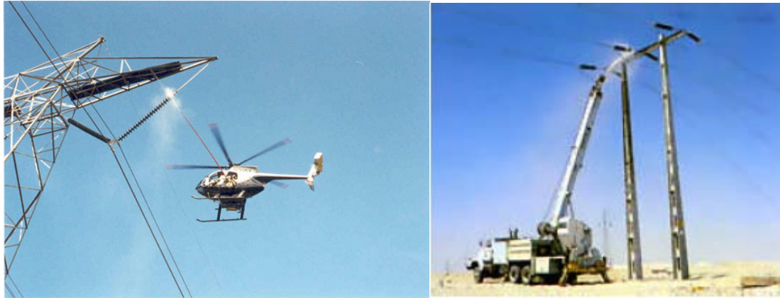
Σχήμα 1.15: Πλύσιμο μονωτήρων σε γραμμές μεταφοράς.
