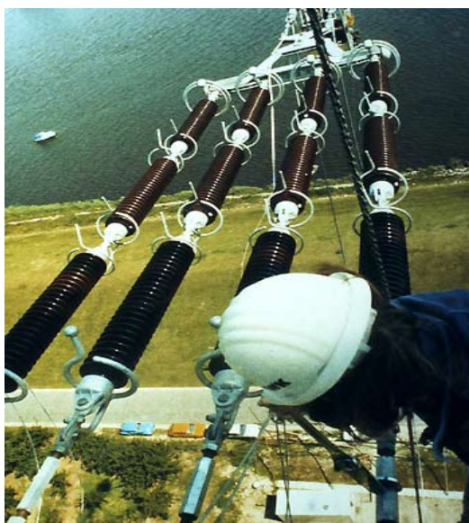
Σχήμα 1.11: Μονωτήρες τύπου longrod (από πορσελάνη).
