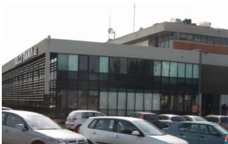
Εικόνα 5.4 Βόρεια πρόσοψη του κτιρίου
