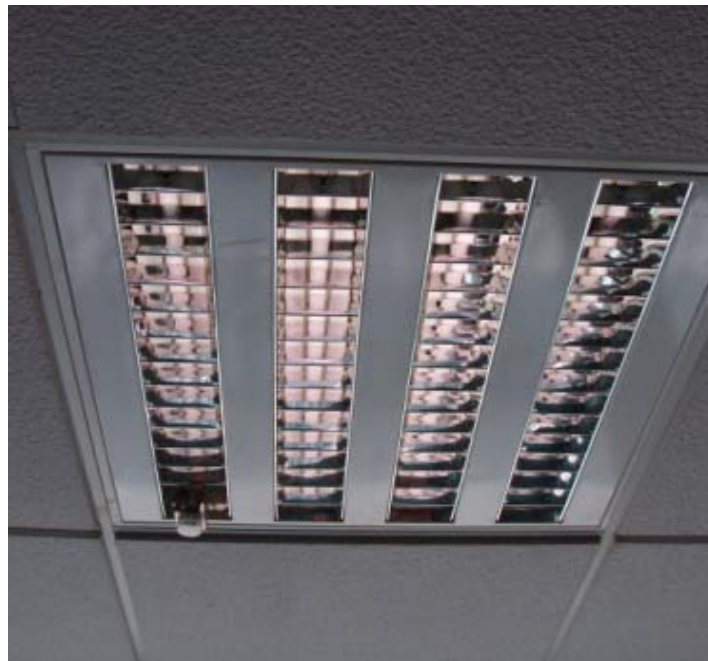
Εικόνα 5.17 Φωτιστικό σώμα της περιμετρικής ζώνης με τον αισθητήρα φωτισμού του
