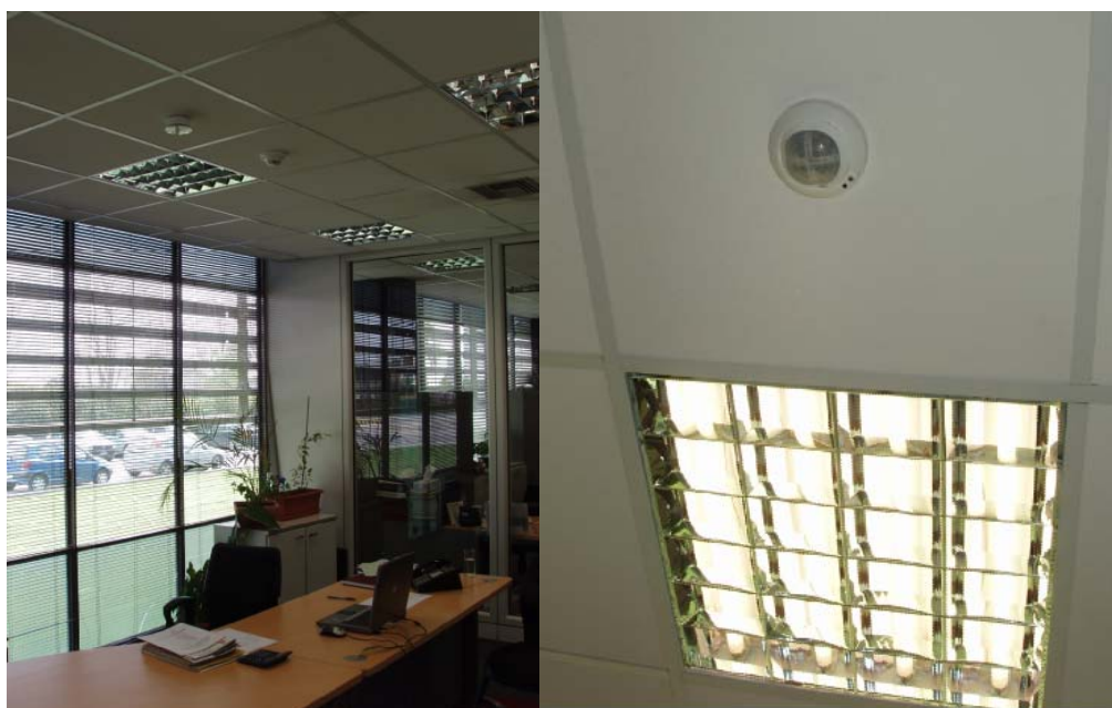
Εικόνα 5.7 Τυπικό γραφείο με αισθητήρες φωτισμού
