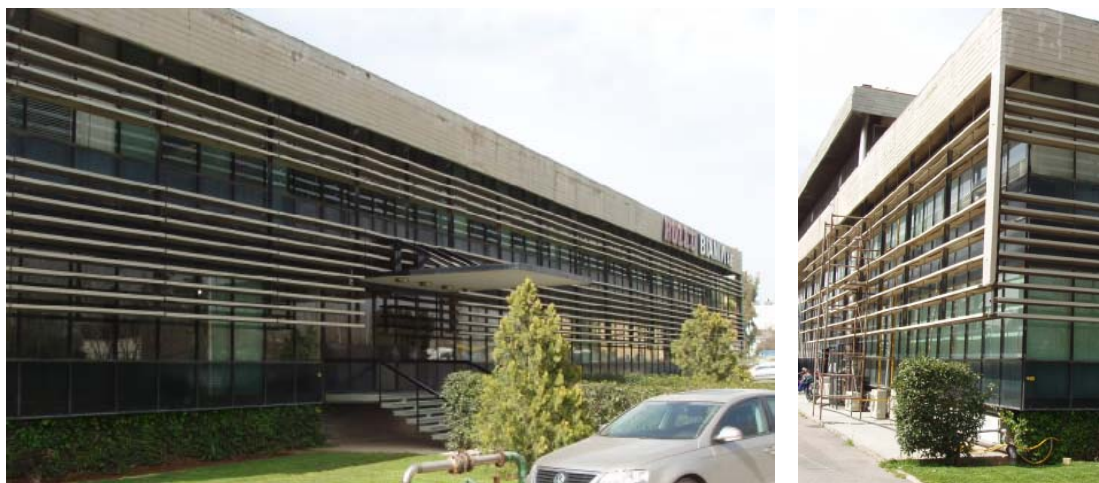
Εικόνα 5.3 Ανατολική και νότια (αντιστοίχως) πρόσοψη του κτηρίου
